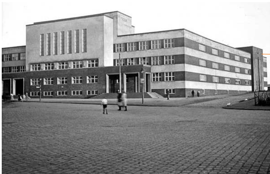
Das Lyzeum am Goetheplatz. Noch mit Flachdach (1932).
