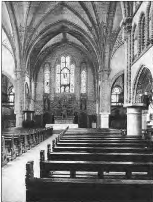
Katholische Kirche, Innenansicht, 1909/10 (Archiv Quade/Reinmuth)
